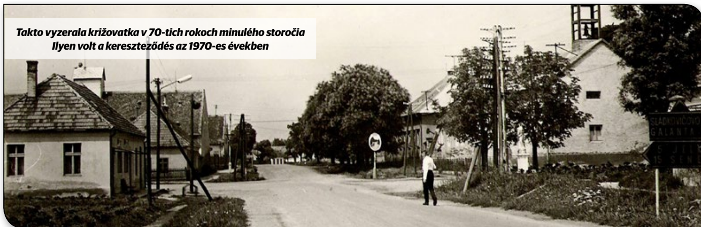
Križovatka pred rekonštrukciou Kereszteződés az átépítés előtt
